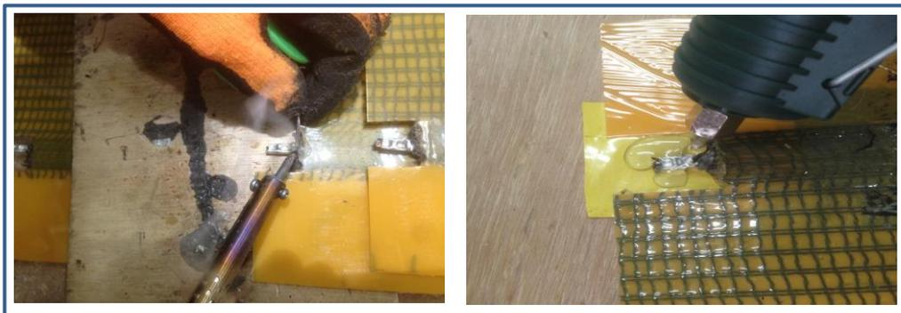
4.電線を固定し、接続が取れないようにハンダで固定、電線を完全に接続します。
