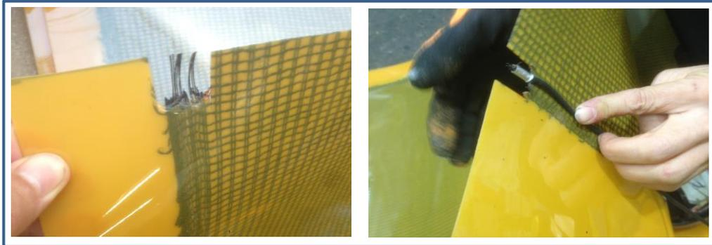
2. 熱風器で接続部分を溶かし、コーティングと炭素が含沈された木綿を除去して電線だけを残しておきます。
