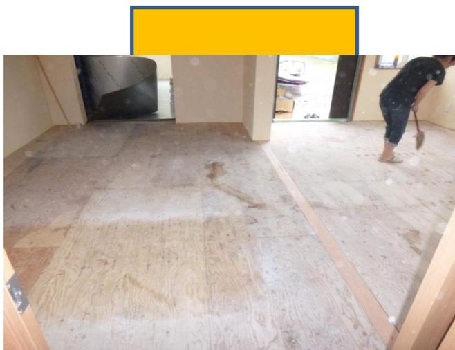
1.施工前に、工事する底に汚物および突出した部分を完全に除去します。底の異質物は断熱材の接着を邪魔して突出した部分は、発熱体を損傷させます。なるべく平らな状態にて行ってください。
