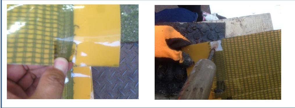
1.電源帯先端3cm程度の箇所をハサミで切ります。P Vウレタンと木綿を熱で吹き飛ばします
