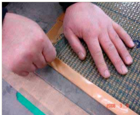
絶縁テープで発熱体の裁断部位を絶縁を行う
