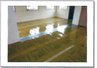
22畳間に設置完了
