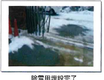
除雪用埋設完了
