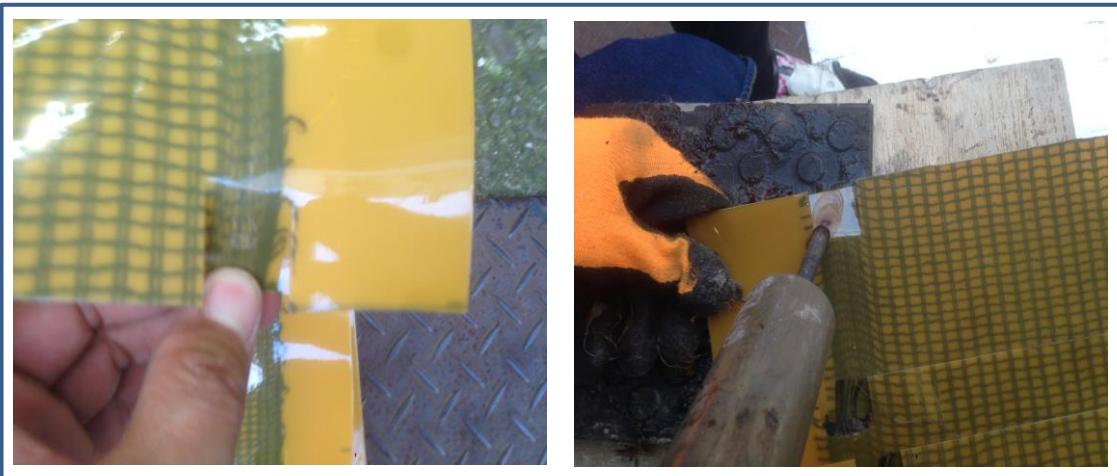
1. 電源帯先端3cm程度の箇所をハサミで切れます。 PVウレタンと木綿を熱で吹き飛ばします。
