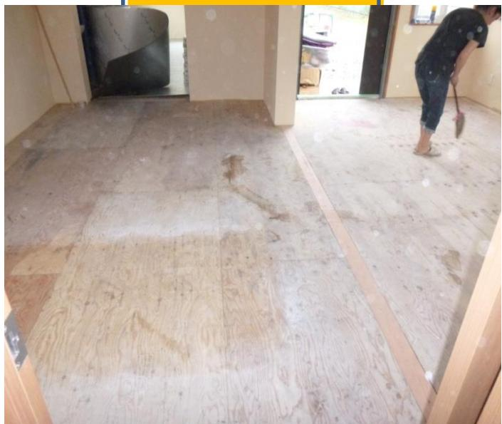
1.施工前に、工事する底に汚物および突出した部分を完全に除去します。底の異質物は断熱材の接着を邪魔して突出した部分は、発熱体を損傷させます。なるべく平らな状態にて行ってください。
