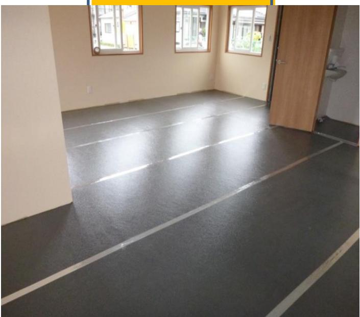
3.断熱材と断熱材の間の繋ぎ目にはOPPテープ（両面テープ）や養生テープを付けて完全に固定します。
