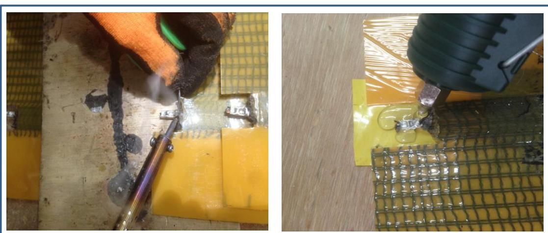
4. 電線を固定し、接続が取れないようにハンダで固定、電線を完全に接続します。
