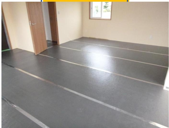
2.断熱材は敷設面積の大きさで裁断をします。発熱体は施工場所より小さく施工をしても、断熱材は施工場所と同一に敷いて施工場所の段差をないようにします。また、配線のための空間ともなります。
