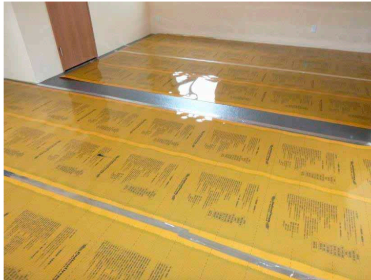
エンドレスドリーム敷設様子 (36㎡部分全面の約80%)
